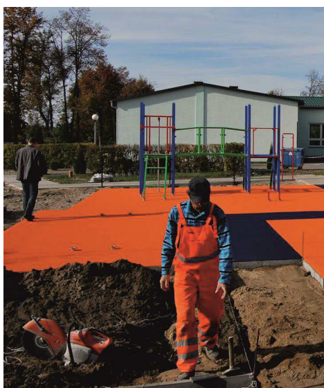
Prace budowlane w Dziadowicach
