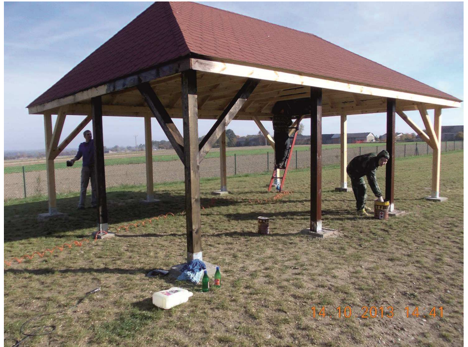
Prace konserwatorskie przy altanie
